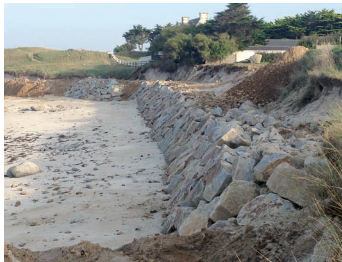
Chantier à Kerlouan (29) - 2014.
