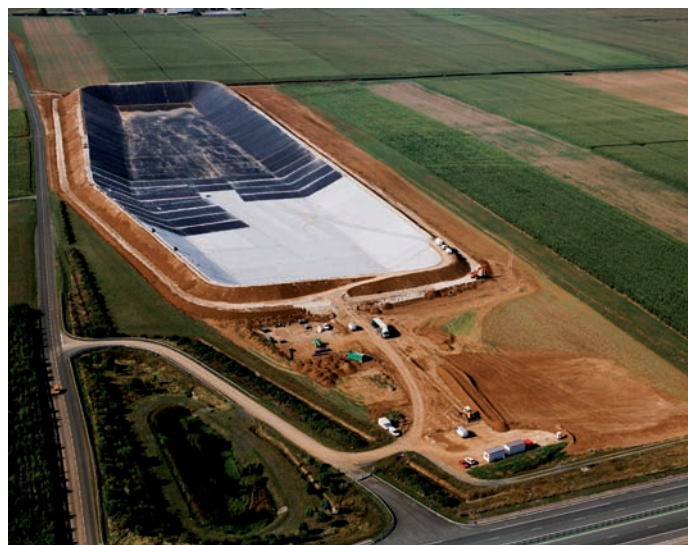
Chantier du bassin des Autizes (Marais Poitevin) - 2006 et 2008.
