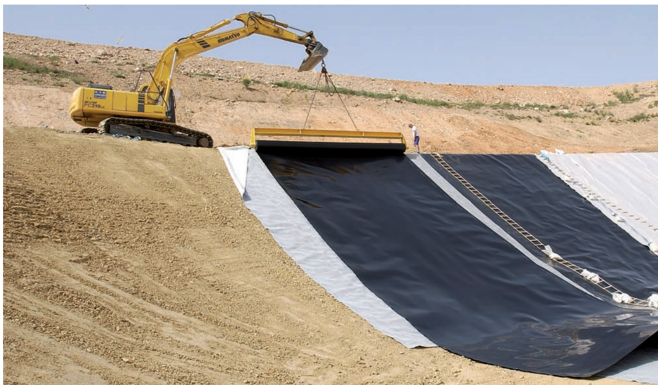
Chantier de Septèmes-les-Vallons (13) : TenCate Bidim® P protège la géomembrane de toute perforation.
