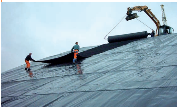
Mise en œuvre d'un géosynthétique TenCate Geolon® Robulon .
