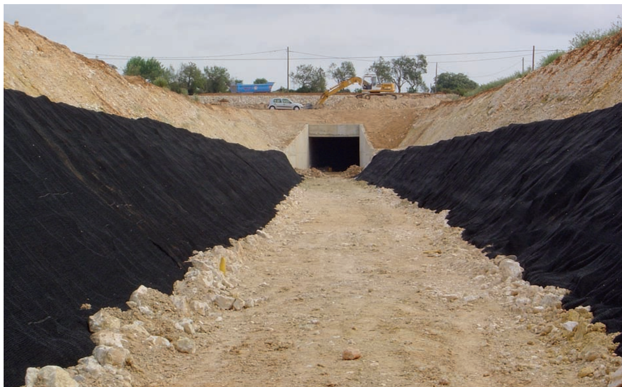
TenCate Geolon® Robulon PP renforce les talus et permet la végétalisation.
